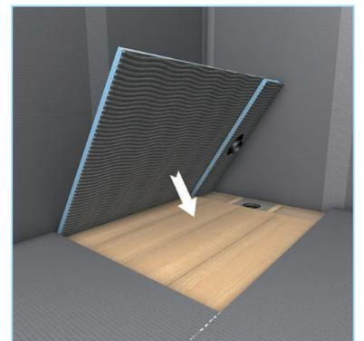
Des panneaux de construction wedi peuvent également être utilisés pour compenser la hauteur aux pourtours du receveur.
